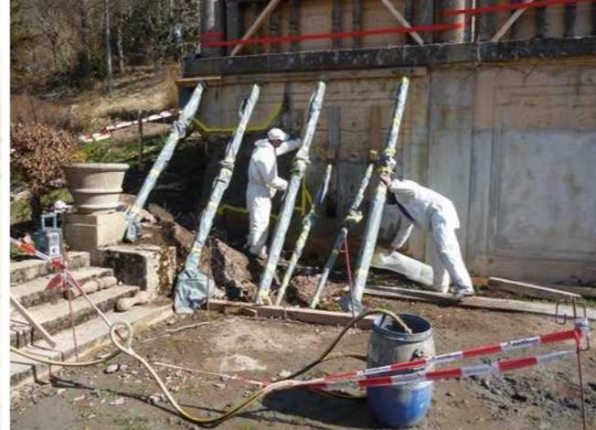
März/April 2017: Soforthilfe tut not – Sanierung eines Stützmauerbruchs durch eine Spezialfirma. Außerdem: Mitarbeiter des städtischen Bauhofs verlegen Leerrohre und schaffen somit die Basis für die künftige Wasser- und Stromversorgung im Park.
